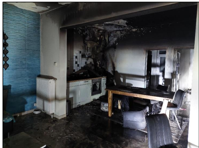
figuur 10 Er is een brand geweest in deze keuken. Twee CO-metingen met een (half) uur ertussen kunnen helpen bepalen of de brand echt geblust is. (Foto: Edward Savat)
