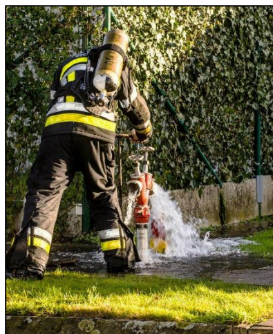
Immagine 1 Un vigile del fuoco monta una tubazione all'idrante. (Foto: Pierre-Henri Demeyere)
