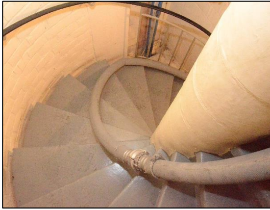
Image 7 Vue de l'escalier en colimaçon avec le tuyau de la colonne montante mobile. (Photo : Luc Van Ussel)
