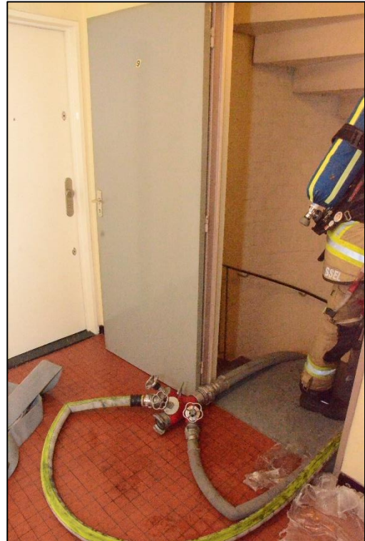
Image 6 La division à trois voies à l'extrémité du tuyau de la colonne montante mobile. Un tuyau de 70mm y alimente, tandis que deux tuyaux de 45mm partent à l'étage supérieur (photo : Luc Van Ussel).
