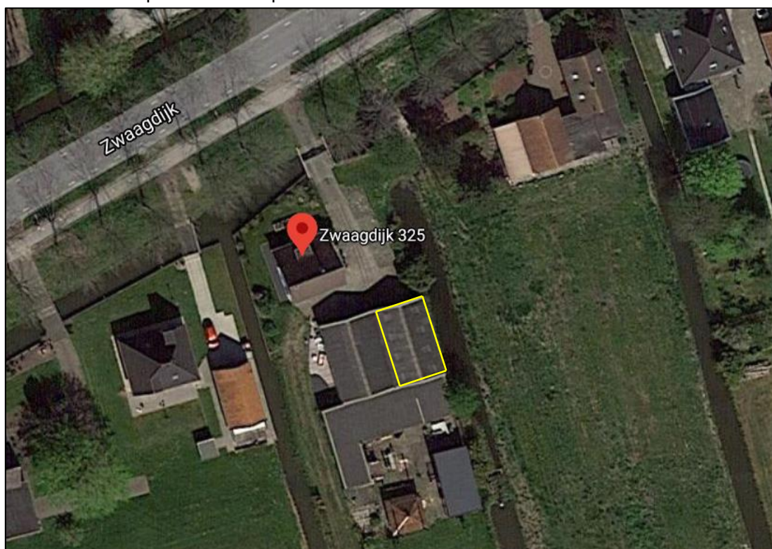
Figura 3 Immagine aerea della situazione. Il tetto a due falde su ciascuno dei capannoni è chiaramente visibile. Il capannone sul lato destro (all'interno del rettangolo giallo) in questa immagine è quello che è bruciato. (Immag.: Google Maps)
