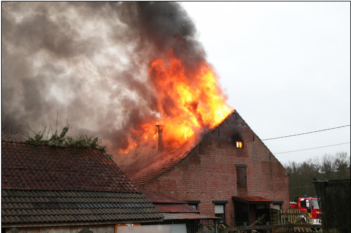
Figura 5 Incendio in una casa. Il fuoco infuria sul tetto. Travi di legno collegano le campate con le altre parti dell'edificio. Con il passare del tempo, queste travi bruceranno e le campate potrebbe cadere verso l'esterno. (Foto: Frank Boelens)
