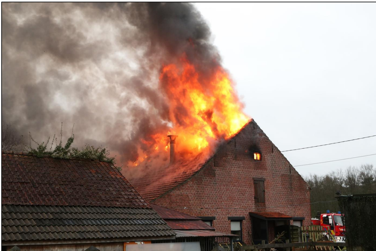
Figure 5 Incendie dans une maison. Le feu fait rage à travers le toit. Des poutres en bois relient le pignon aux autres parties du bâtiment. Au fil du temps, ces poutres vont brûler et le pignon risque de tomber vers l'extérieur. (Photo : Frank Boelens)
