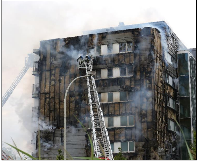
Şekil 4 Ypres yangınından sonra, dış cephede çok az yakıt kalmıştı. (Fotoğraf: Warre Saint-Germain)
