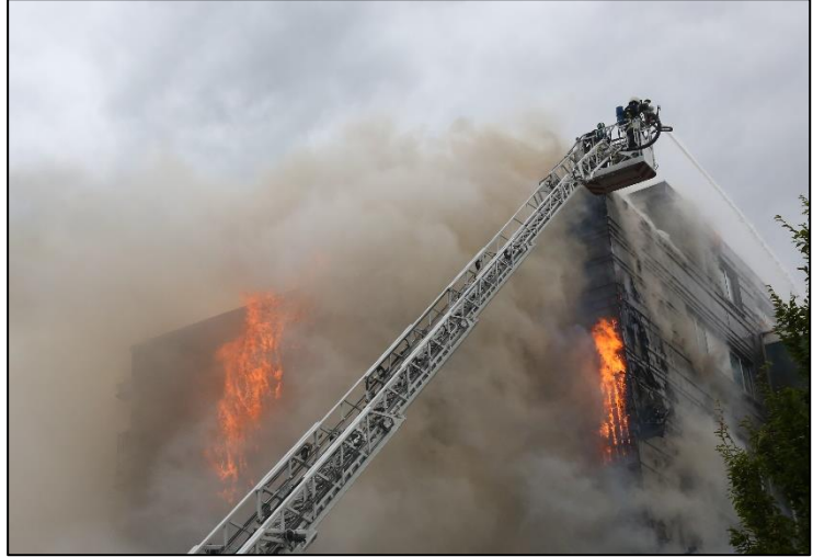
Şekil 2 Ypres'deki dış cephe yangını. Bazı kısımlarda dış cephe "açılmış" ve alevler görünüyor. Diğer yerlerde ise dış cephe hala "kapalı" ve fazlaca duman çıkıyor. (Fotoğraf: Warre Saint-Germain)
