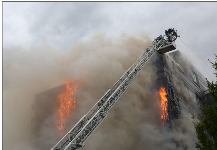
Bild 2 Der Fassadenbrand in Ypern. Deutlich zu erkennen, wie an manchen Stellen die Fassade bereits "offen" ist und Flammen zu sehen sind. An anderen Stellen ist die Fassade noch "verschlossen" und große Mengen Rauch werden freigesetzt. (Bild: Warre Saint-Germain)
