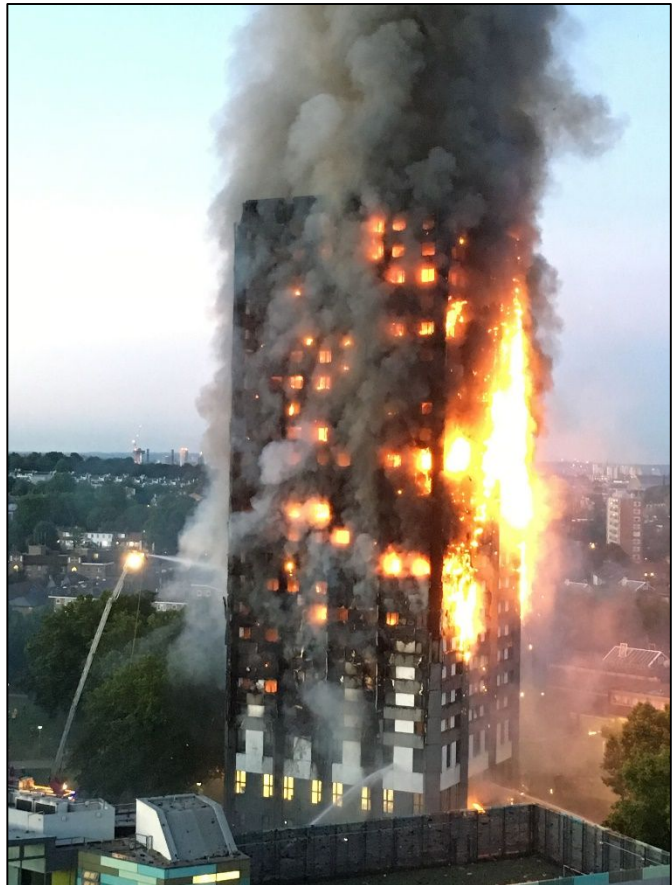
Bild 1 Der Brand entstand in einer Wohnung auf der 4ten Etage und breitete sich anschließend schnell über die Außenfassade aus. Danach bewegte sich das Feuer wieder zurück von außen nach innen.
