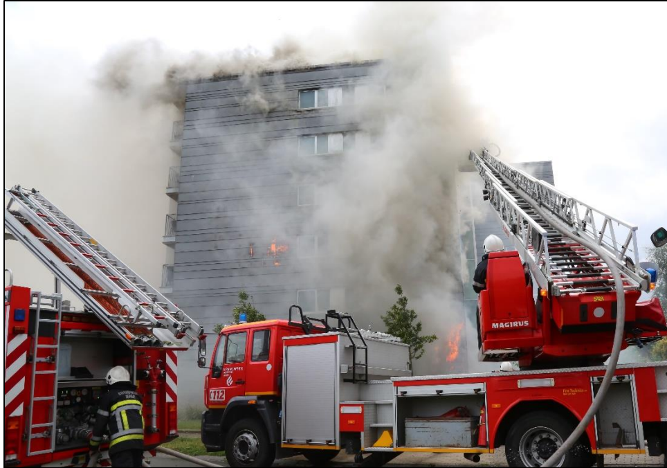
图 3: 比利时伊普尔火灾现场, 产生了大量的烟气。照片显示建筑外层基本完好无损。主要是因为, 只有很少的氧气能达到外部绝缘层, 反过来这又导致了烟气的增加, 烟气被推到了房顶。此类火灾发生时, 烟气可能会充满整栋建筑。(图片: Warre Saint-Germain)
