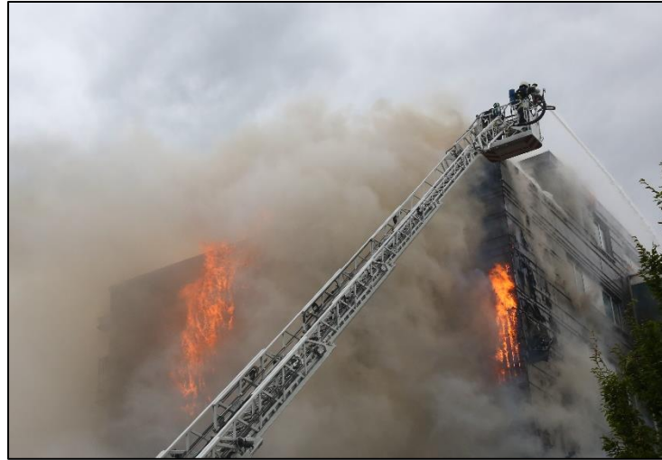
图2 比利时伊普尔的保温层火灾。图中某些位置是敞开的，我们可以看到火焰；另一些地方是关闭的，能看到浓烟冒出（图：Warre Saint-Germain）
