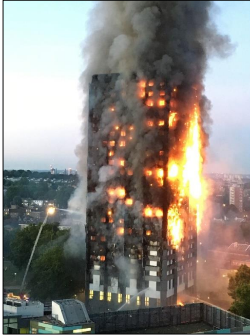
图1 起火点位于建筑4楼的单元房，蔓延至外保温层，最后火灾从外部向内燃烧
