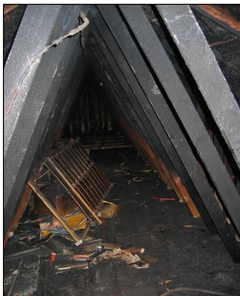
figure 2 Vue de l'échelle dans le grenier. La photo montre à quel point le grenier est étroit. (Photo : Service d'incendie Westhoek - station Diksmuide)
