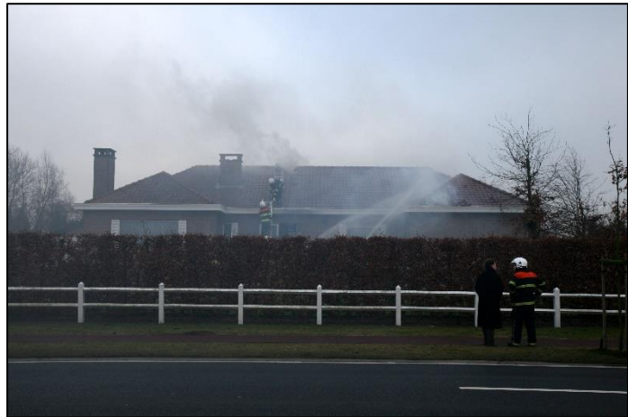
Figura1 Bomberos en la escena de la casa en Diksmuide. Esta foto fue tomada mucho después de la hora de llegada. (Photo: Fire service Westhoek – station Diksmuide)
