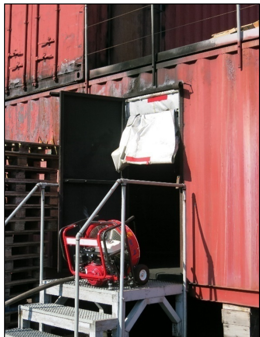
Figura 6 La cortina bloqueadora cierra la mitad superior de la abertura de la puerta. El flujo hacia atrás causado por el ventilador se limita. El ventilador puede ser colocado más próximo a la puerta. (Picture: Michael Reick)
