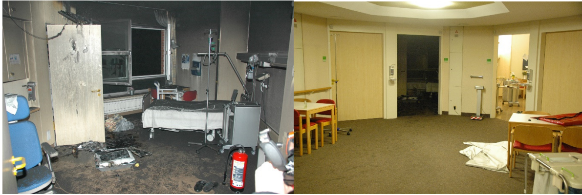
Figura 9 Incendio en un hospital en Alemania. La imagen de la izquierda muestra que la habitación del hospital estaba completamente llena de humo. El de la derecha muestra el pasillo. En el medio de la figura hay una puerta que lleva a la habitación del incendio. No hay daño de humo en el pasillo. La Cortina bloqueadora está en el suelo en la parte de debajo de la derecha. (Photo: Michael Reick)
