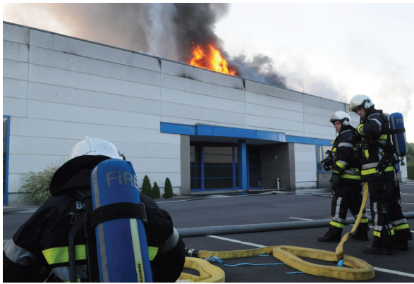
Bild 4 Brand in einem Industriegebäude, das aus vorgefertigten Betonelementen gebaut wurde. Wegen der Einsturzgefahr halten die Einsatzkräfte großen Abstand zu den Mauern. Danach werden die losen Teile der Fassade beseitigt, um die Einsturzgefahr auszuschließen. (Fotos: Peter Vangierdegom)
