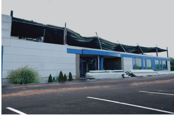
Bild 4 Brand in einem Industriegebäude, das aus vorgefertigten Betonelementen gebaut wurde. Wegen der Einsturzgefahr halten die Einsatzkräfte großen Abstand zu den Mauern. Danach werden die losen Teile der Fassade beseitigt, um die Einsturzgefahr auszuschließen. (Fotos: Peter Vangierdegom)
