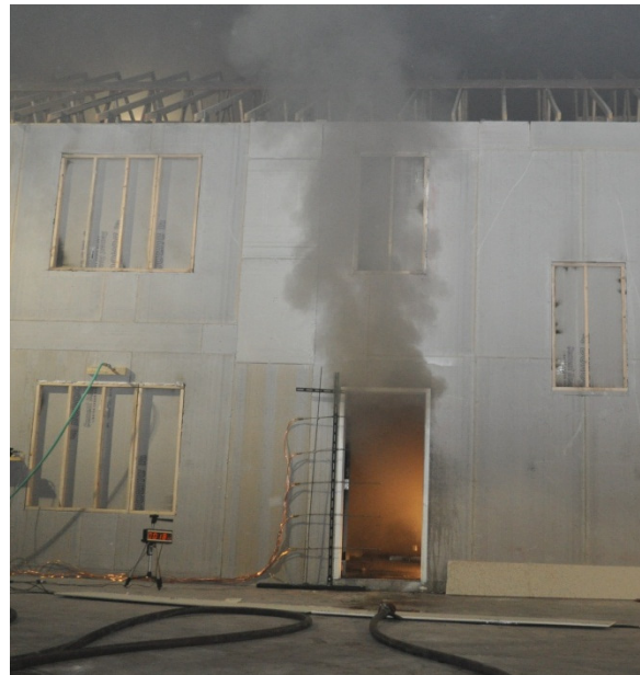
Fig. 2.1 Humo saliendo a través de la parte superior de la puerta mientras el resto de la puerta está siendo usada para el suministro de aire fresco. El aire fresco permitirá un crecimiento rápido del fuego. (Photo: Steve Kerber – Underwriters Laboratories)
