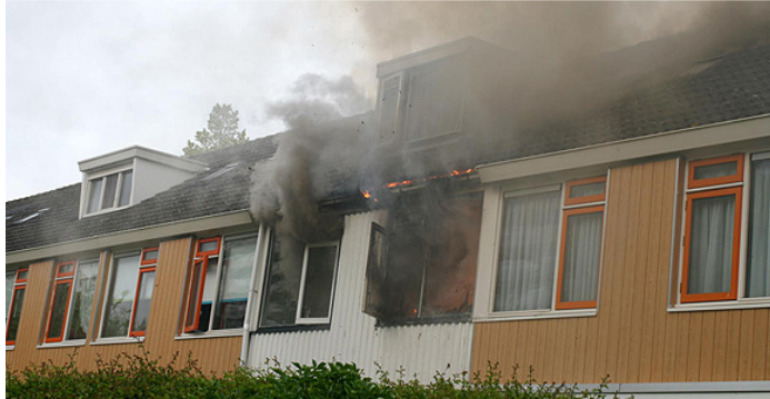
Fig 2.1 Bij een dergelijke brand kan de achtergevel een compleet ander beeld geven dan de voorgevel
