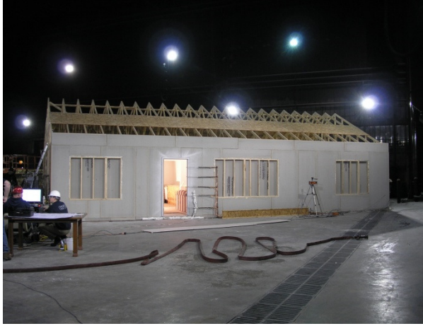
Şekil 2.1 Tek katlı ev (112 m 2 ) (Foto: UL)
