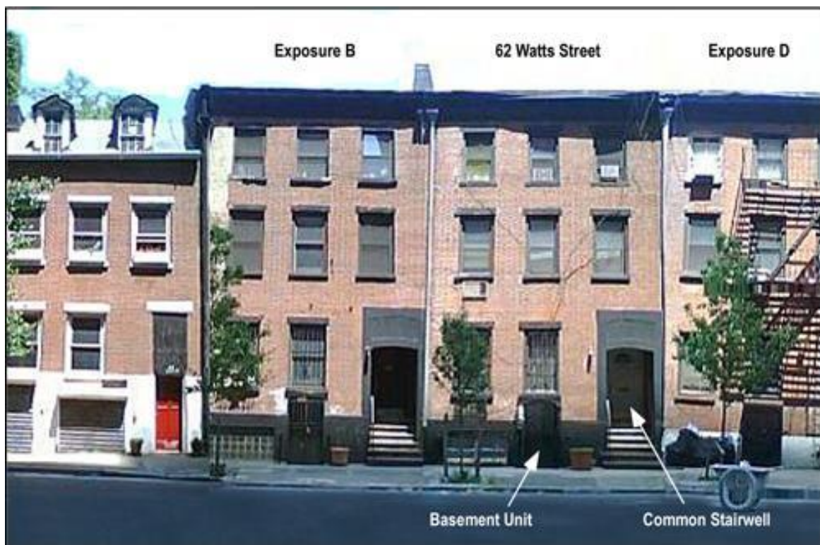
Σχήμα 1.1 Άποψη της οδού Watts 62. Ένα πανομοιότυπο κτίριο φαίνεται στα αριστερά του. Δεξιά υπήρχε ένα παρόμοιο αλλά όχι πανομοιότυπο κτίριο.
