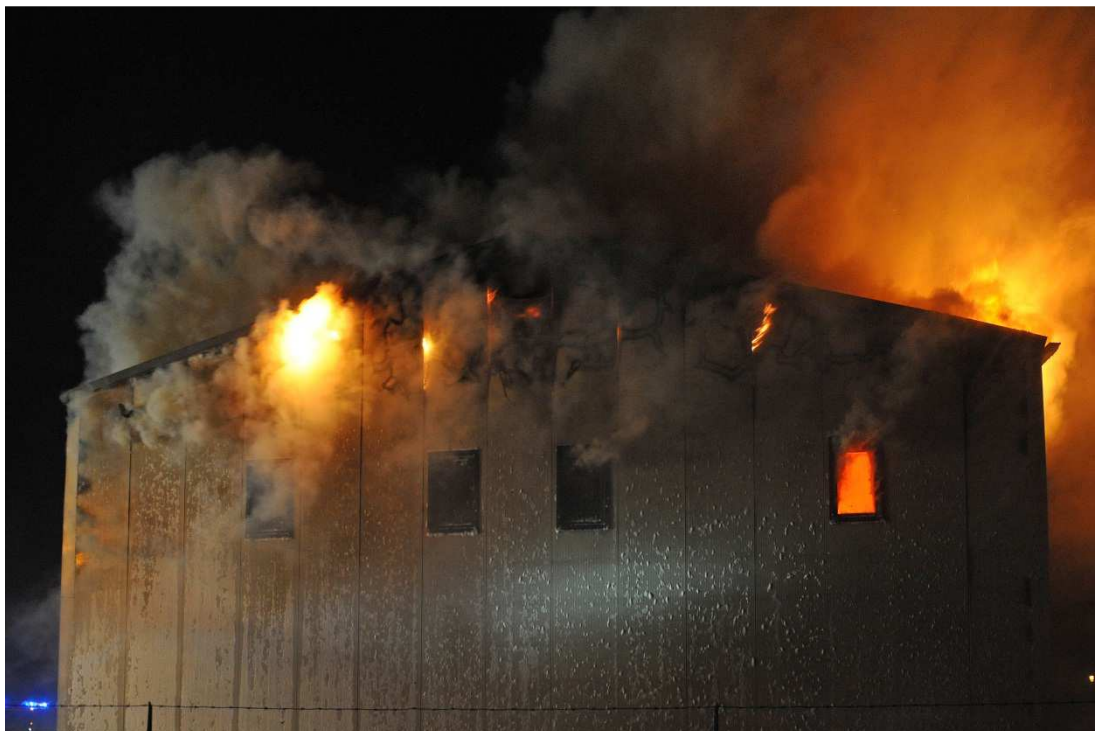
Afbeelding 2 1:14 uur, onverbrande gassen worden naar buiten geperst en verbranden aan de achterzijde in de buitenlucht na het forceren van openingen (foto Joachim de Ruijter)
