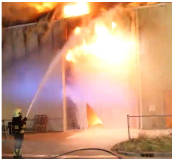
Afbeelding 14 Groeiende brand, uitgassende panelen
