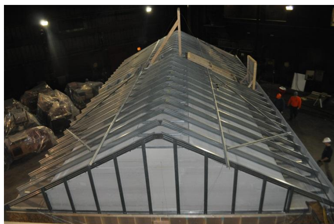
Figuur 3.2: Dak bungalow
