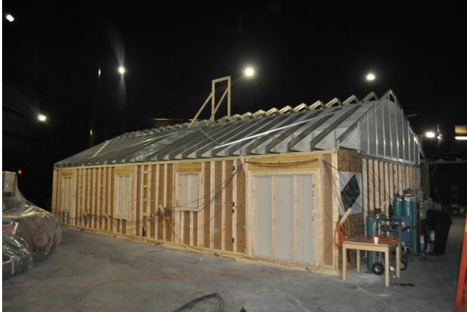
Figuur 3.3: Achterzijde bungalow
