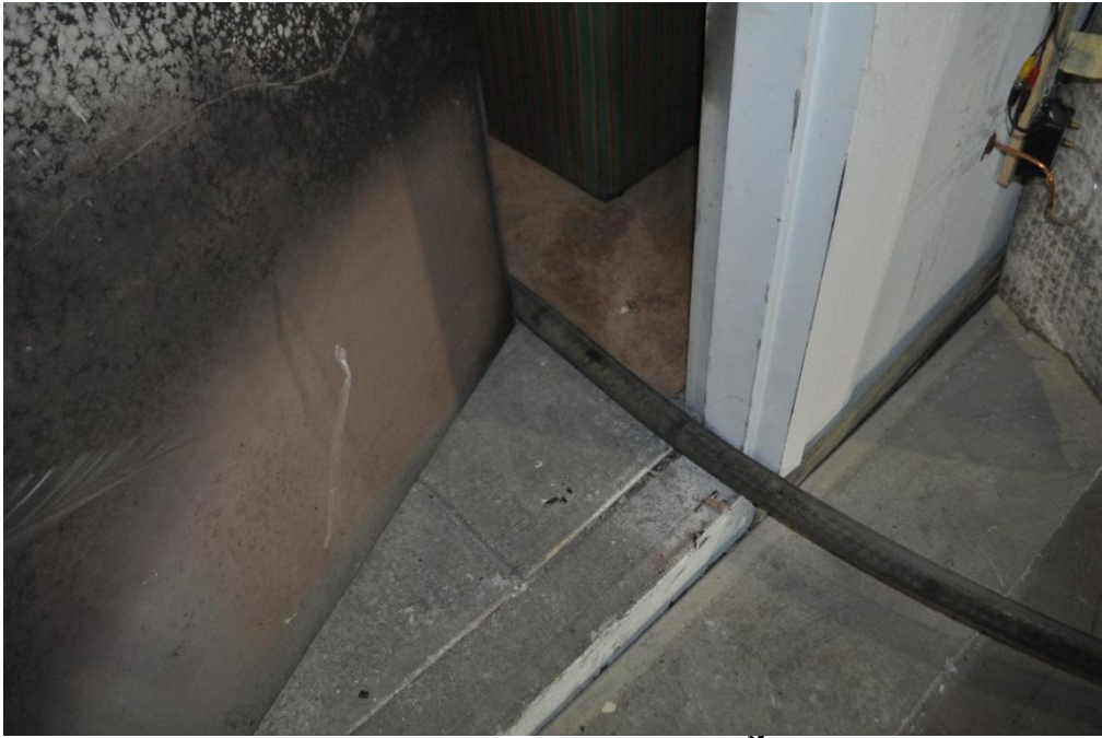
Figuur 4.2: Gecontroleerde deurbediening met een 1 3/4 inch 35 brandslang
