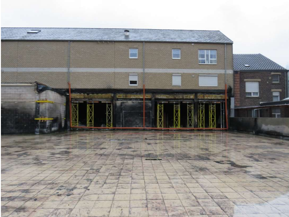
Vue de l'emplacement du Zeeman après démolition
