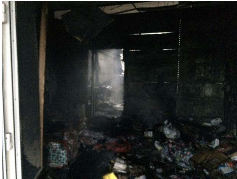
Vue de la réserve située sous l'immeuble de logement après l'incendie
