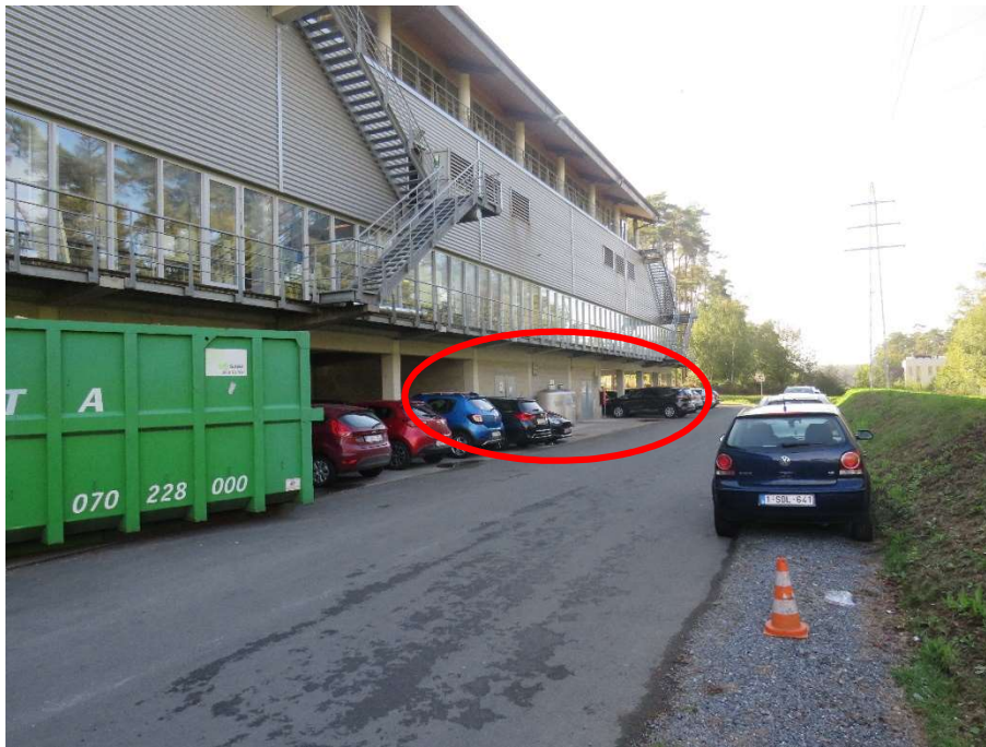
Vue sur le local des énergies depuis la façade delta
