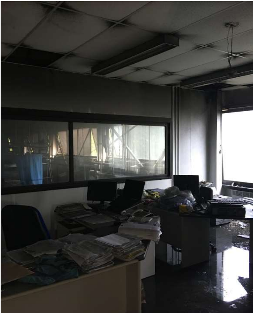
Figuur 23 Kantoorruimte 1ste verdieping met vals plaffond
