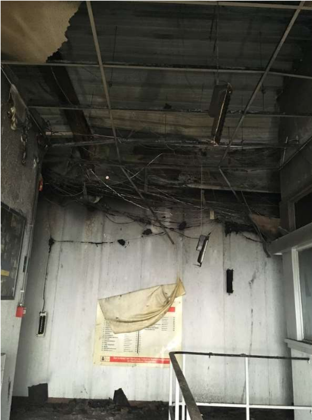
Figuur 24 Doorslag vals plafond traphal D-zijde
