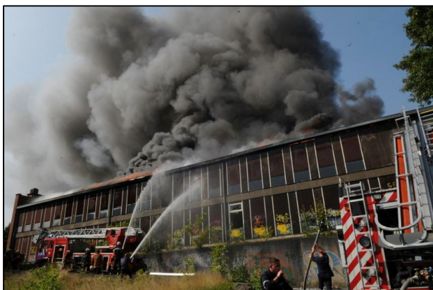
Figuur 6 De zijgevel van gebouw B. Alle ramen zijn dichtgetimmerd behalve één. De stagiaire-officier ontsnapt uit het gebouw langs deze opening. (Foto: Robert Decock)
